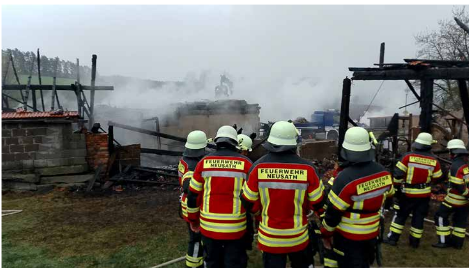
Einsatzkräfte sind überwältigt über das Ausmaß des Schadens
